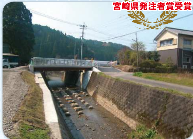
宮崎市（橋梁工事）
