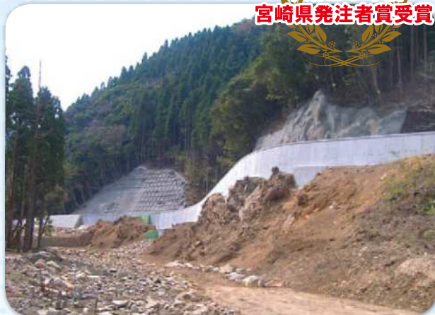
宮崎市（林道工事）
