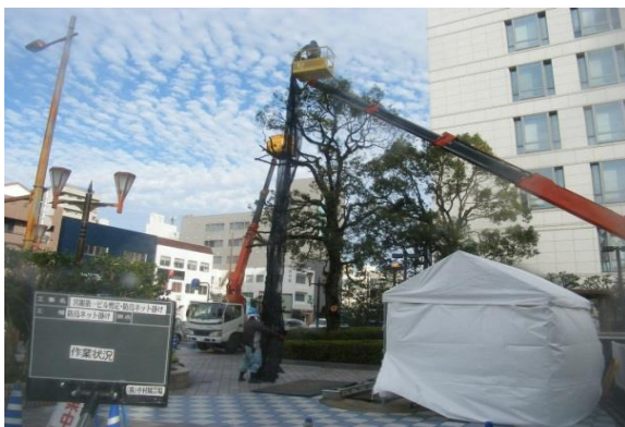
PHOT 2 網設置状況
