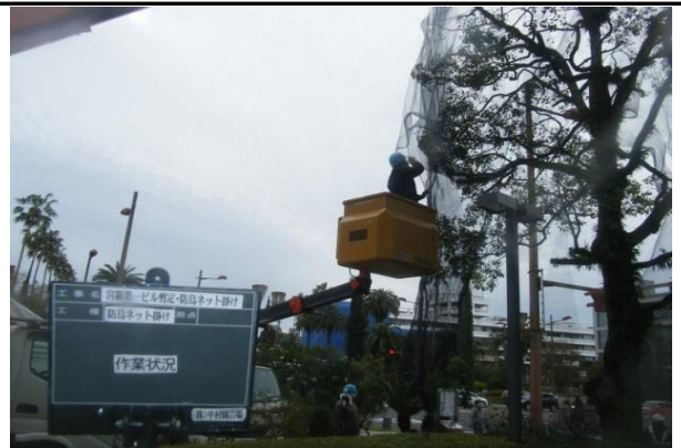
PHOT 3 網設置状況
