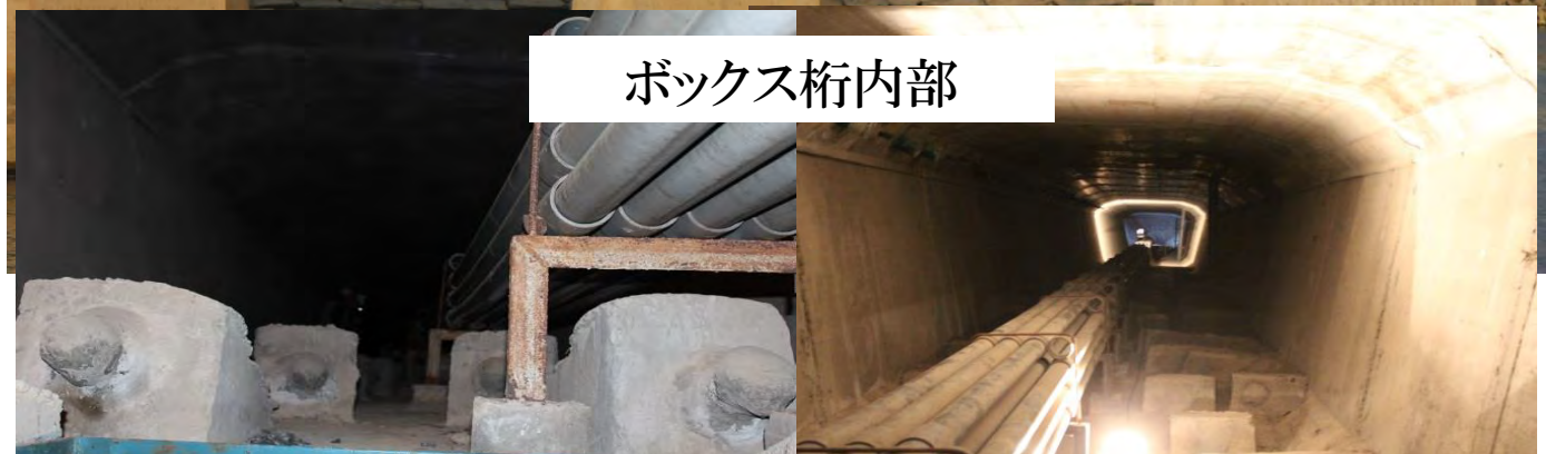
事例③ 大淀大橋 宮崎市 県道341号線
