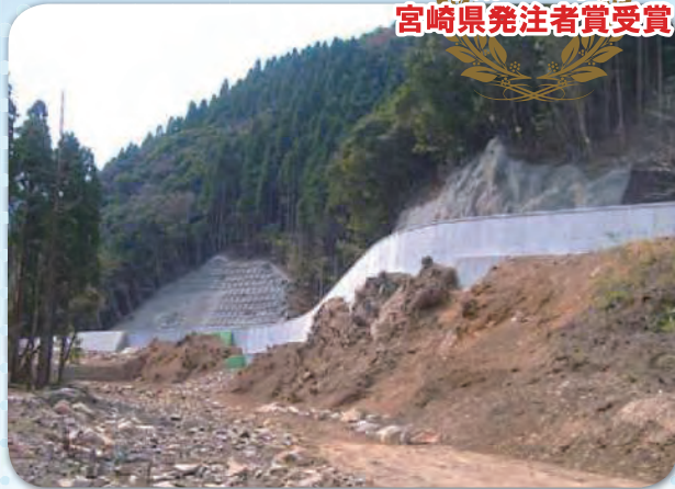
宮崎市（林道工事）
