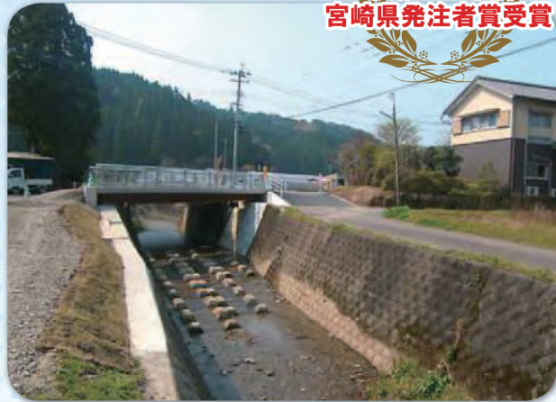
宮崎市（橋梁工事）
